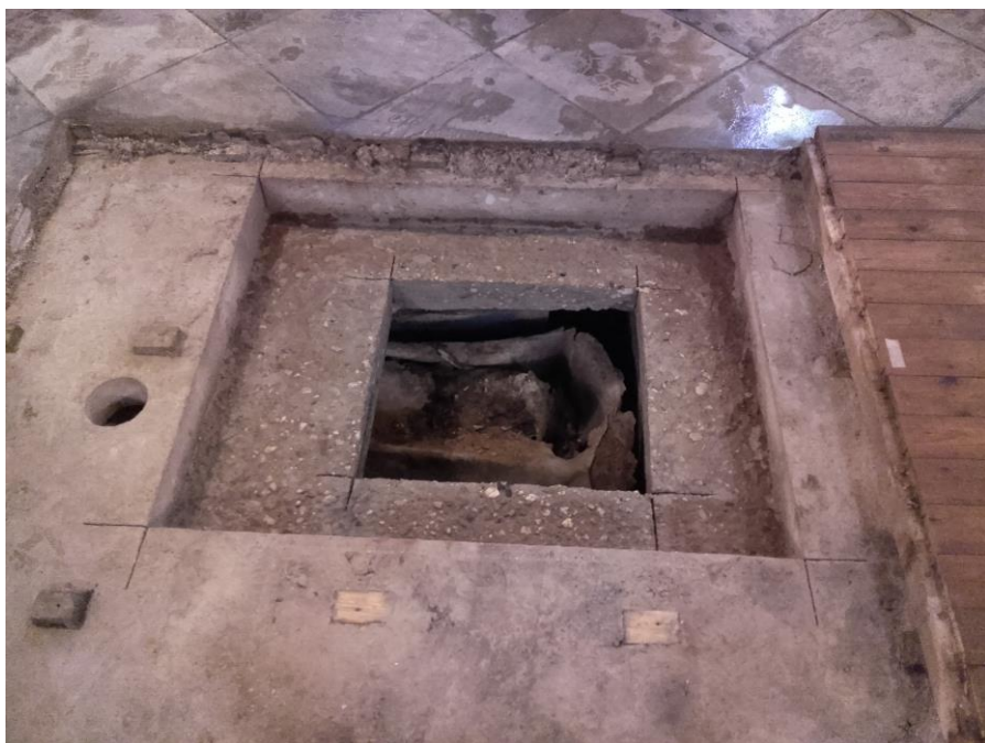
Zaagwerk voor toegang
