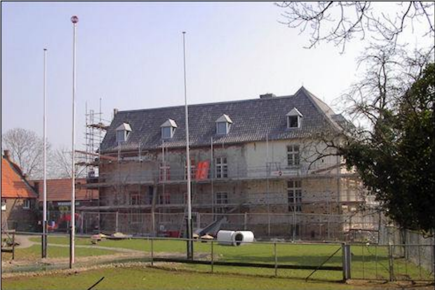
Kasteel Ooijen tijdens de renovatie
