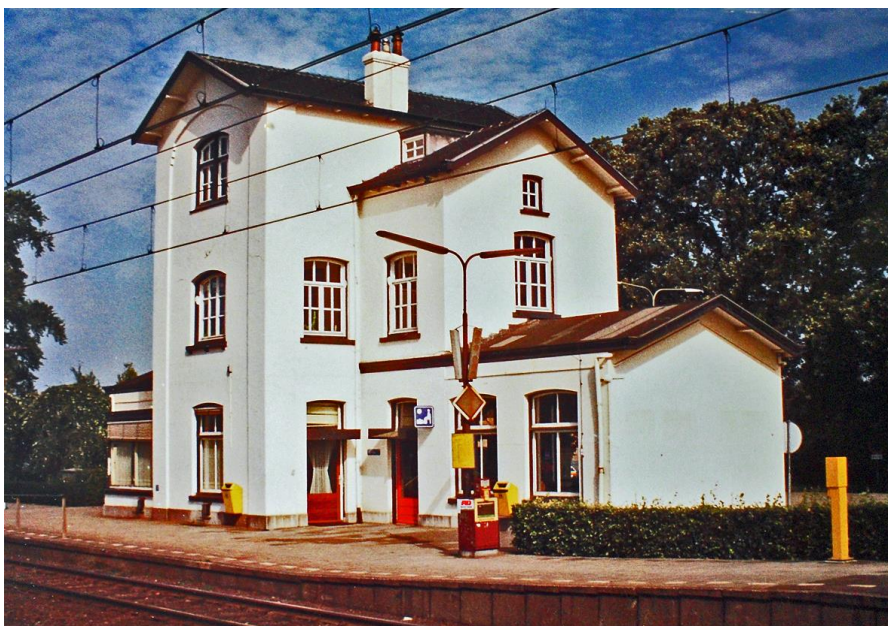
1990 voor de renovatie
