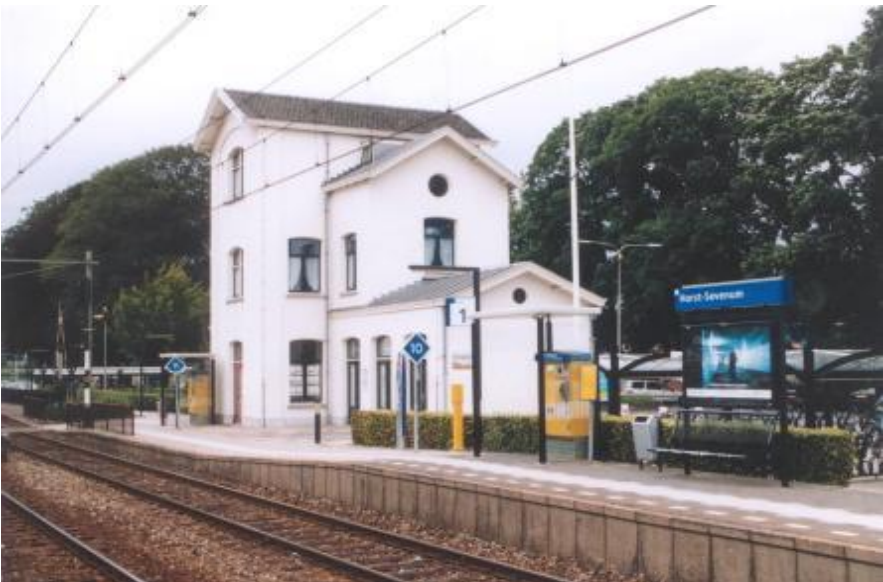
1993 na de renovatie
