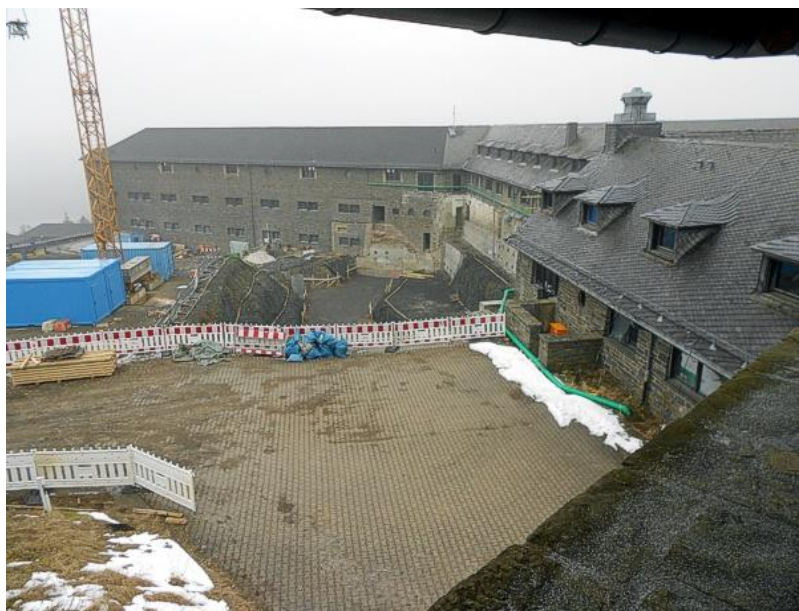
Het complex "Vogelsang" van de architect Clemens Klotz
