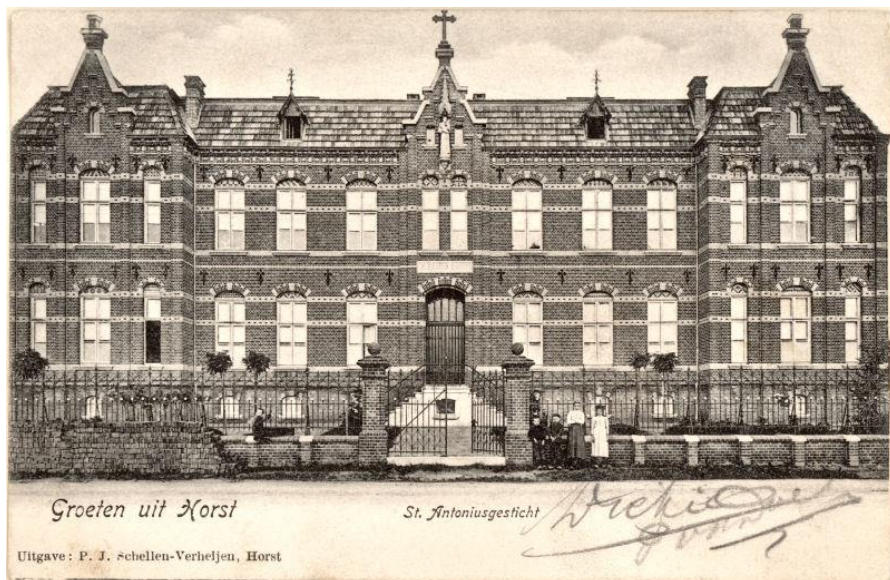
Het Gasthuis. Foto waarschijnlijk genomen vóór 1907. In 1907 werd het gebouw omgedoopt tot ziekenhuis.
